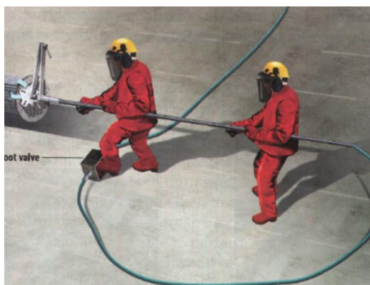
Figura 09 – Operador adicional para auxiliar hidrojetista com mauseio da lança.
